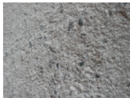
図-2 チップング後のコンクリート表面
