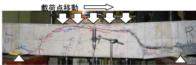
写真-7 破壊時ひび割れ (ケース 6)
