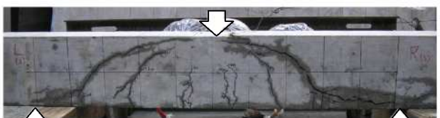
写真-3 破壊時ひび割れ(ケース3)
