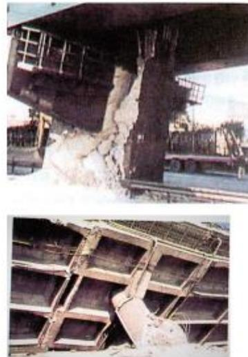
1980年の示方書では、私の意見が採用され、もう一つ重要な変更が行われました。必要せん断補強鉄筋量の非連続性をなくしたのです。せん断応力度が許容値以下であれば、直径6mmの鉄筋を、有効高さ以下の間隔で配置すればよいとされてきており、許容値を越えると全せん断力をいわゆるトラス機構で受け持つ方式をとっていました。必要せん断補強鉄筋量に大きな不連続性があったのです。この規定はせん断補強鉄筋を用いない部材を奨励することになります。断面を多少大きくしてもせん断応力を許容値以下とする設計が、経済的となる場合があるからです。
