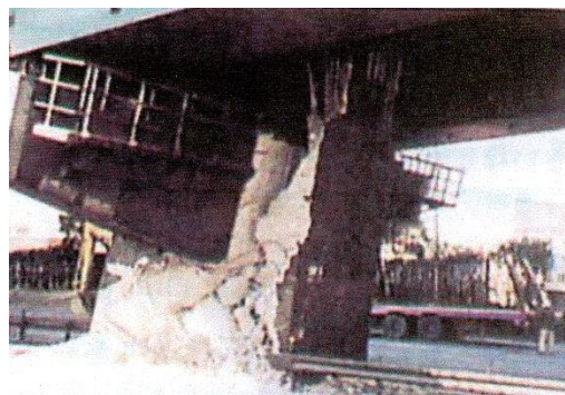
図5 単柱式橋脚の崩壊
